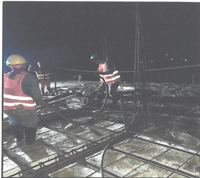
VACEO DE LOSA ALIGERADA EN CONTINGENCIA - ISLANDIA.
