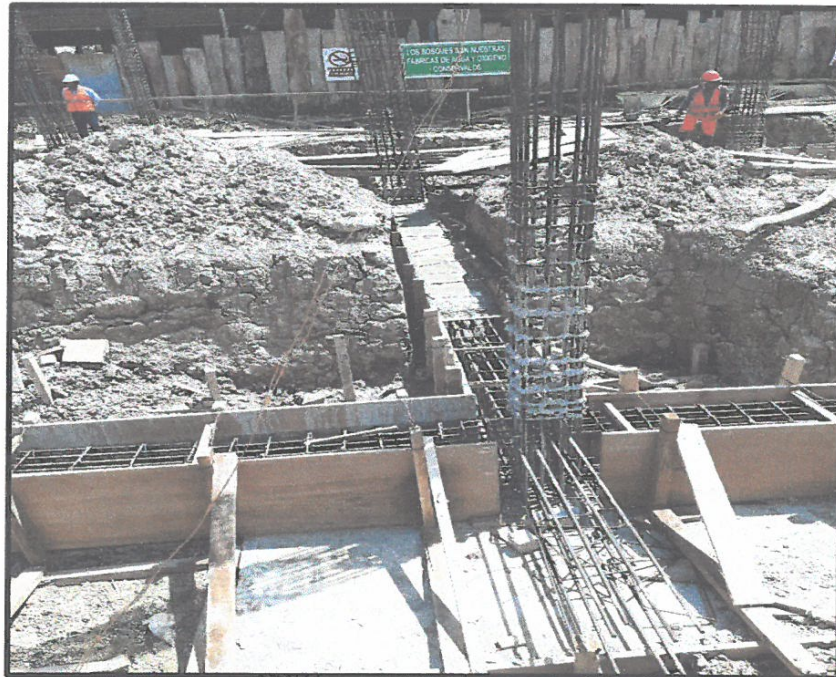
ENCOFRADO DE VIGAS DE CIMENTACIÓN EN C.S ISLANDIA.
