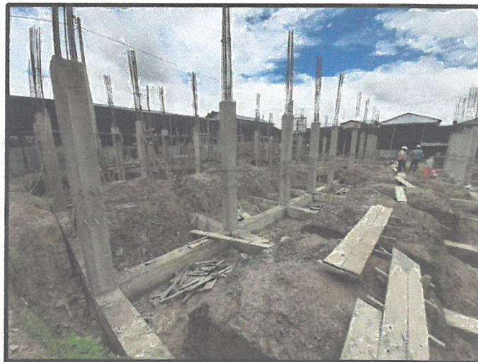
VISTA PANORAMICA DE VACEO EN COLUMNAS EN C.S ISLANDIA.
