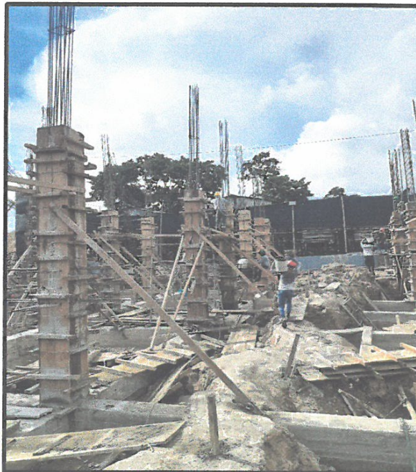
VACEADO CON MORTERO f'c = 210 \text{ Kg/cm}^2 EN COLUMNAS.
