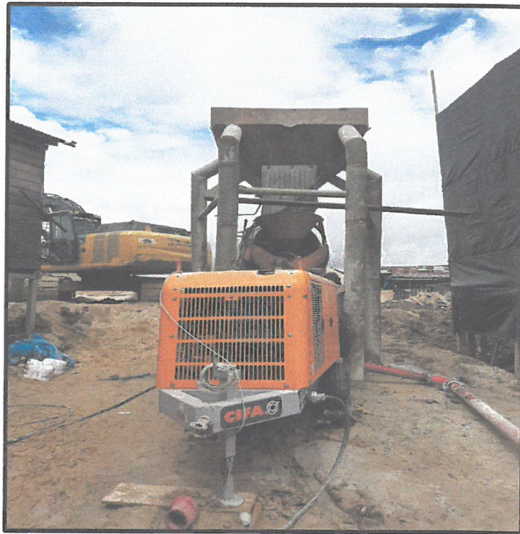
EQUIPO DE VACEO DE MORTERO EN OBRA.
