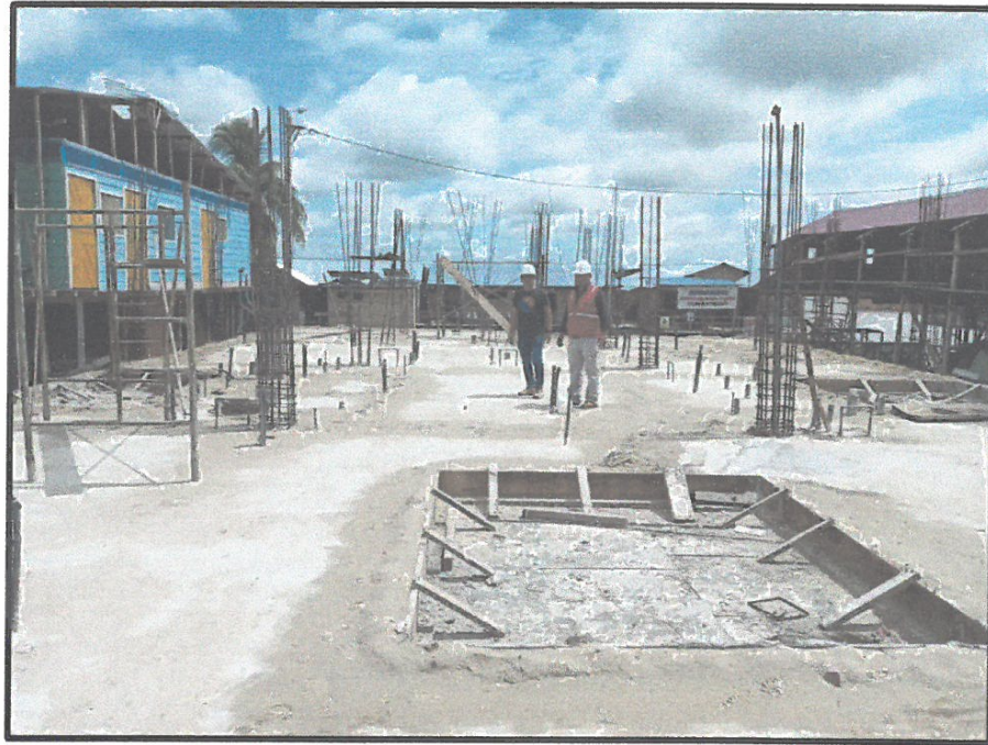
VERIFICACION DE FRAGUADO DE LOSA ALIGERADA EN CONTINGENCIA - ISLANDIA.
