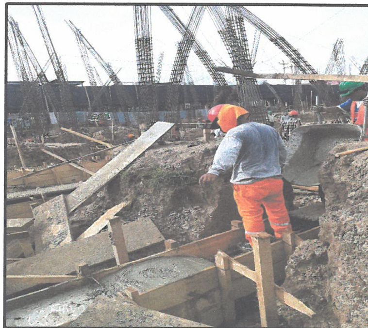
VACEADO CON MORTERO f'c = 210 \text{ Kg/CM}^2 DE VIGAS DE CIMENTACIÓN.
