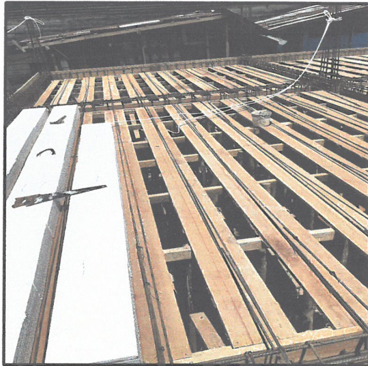
PROCESO DE ENCOFRADO DE LOSA ALIGERADA EN CONTINGENCIA - ISLANDIA.
