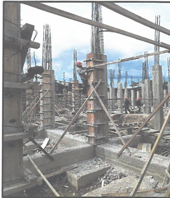
ENCOFRADO Y DESENCOFRADO DE COLUMNAS EN EL C.S ISLANDIA.
